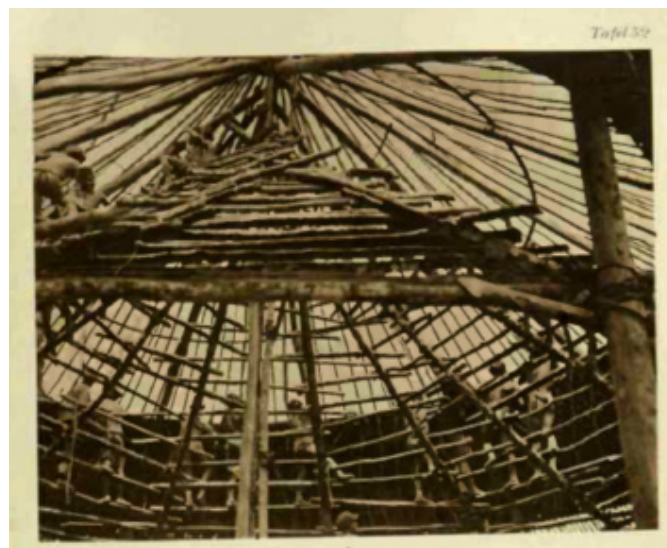
Figura 5. Estrutura de andaime utilizada na construção do ättä. (Foto: Theodor Koch-Grünberg)
