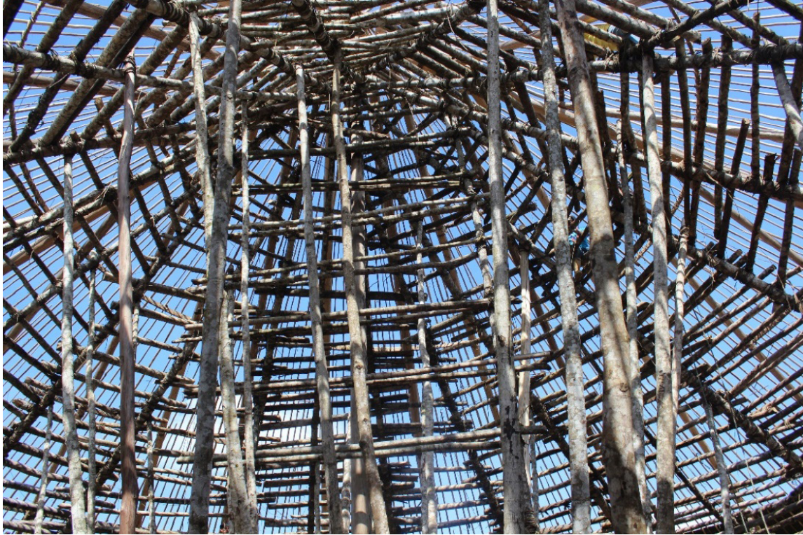
Figura 4. Estrutura de andaime utilizada na construção do ättä (Foto: Pablo Albernaz)
