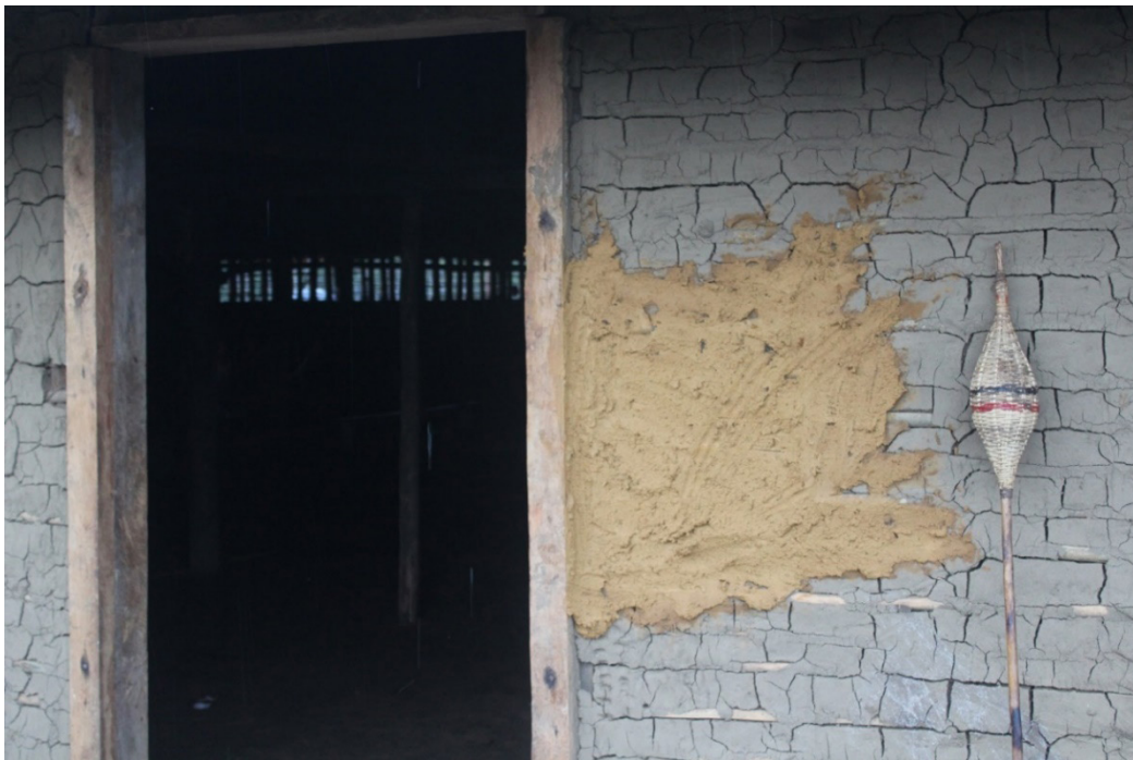
Figura 14. Fechamento da parede da ättä (Foto: Pablo Albernaz)
